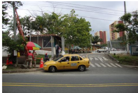
Foto 2: Portería Tecnológico de Antioquia Calle 78 b
