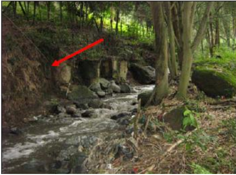
Foto 23. Margen derecha del cauce modelado
