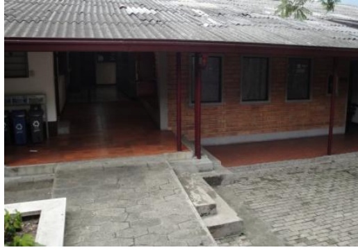
Fotos 6. Bloque A Escuela de Ciencias de la Salud UPB
