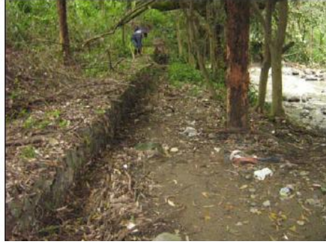
Foto 24. Muro en gavión margen izquierda lote UPB
