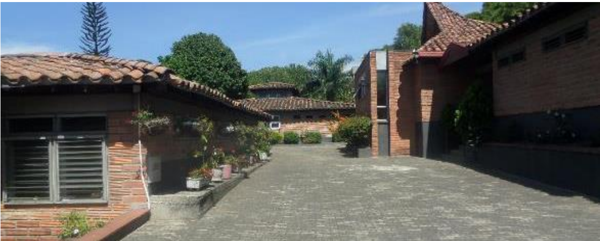
Imagen 40. Infraestructura actual en el predio
