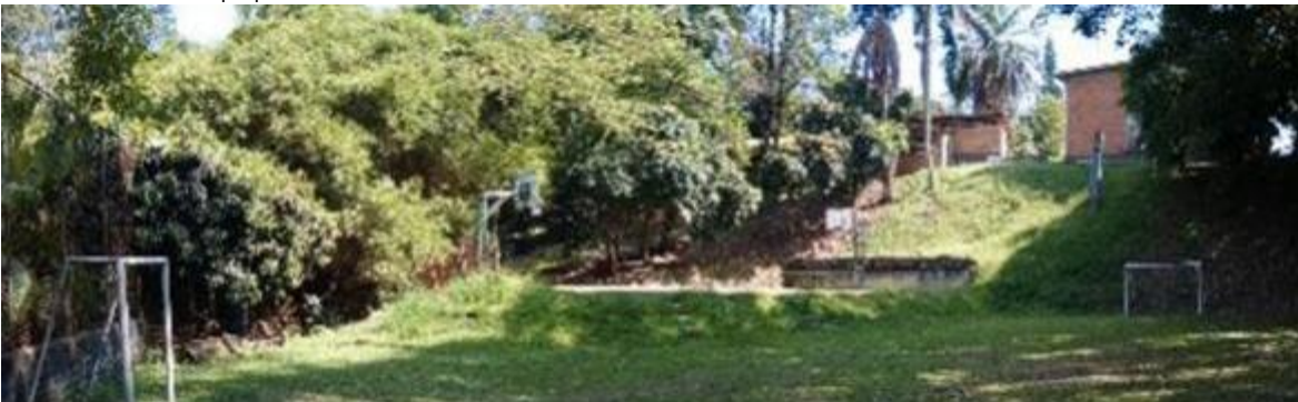
Imagen 36. Zona inferior del predio donde se ha modificado la morfología inicial a través de cortes de taludes, explanación y llenos para adecuar escenarios deportivos. Fuente: Elaboración propia 2014
