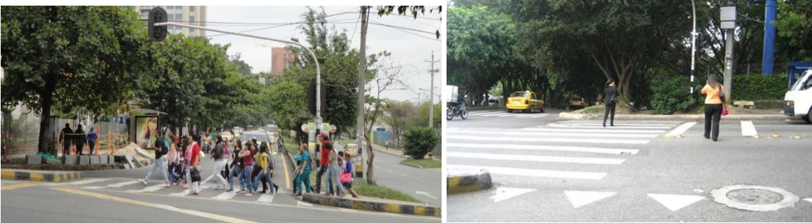
Imagen 78. Demarcaciones y rebajes para el paso peatonal en el cruce de la calle 78B con la carrera 72 A Fuente: Elaboración propia 2014
