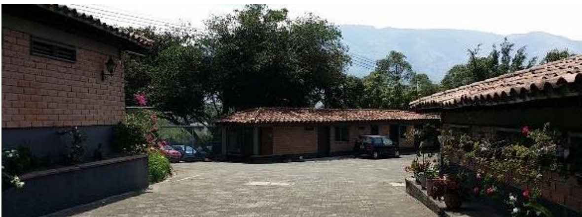
Imagen 2. Noviciado San Estanislao Kotska Fuente: Elaboración propia 2014
