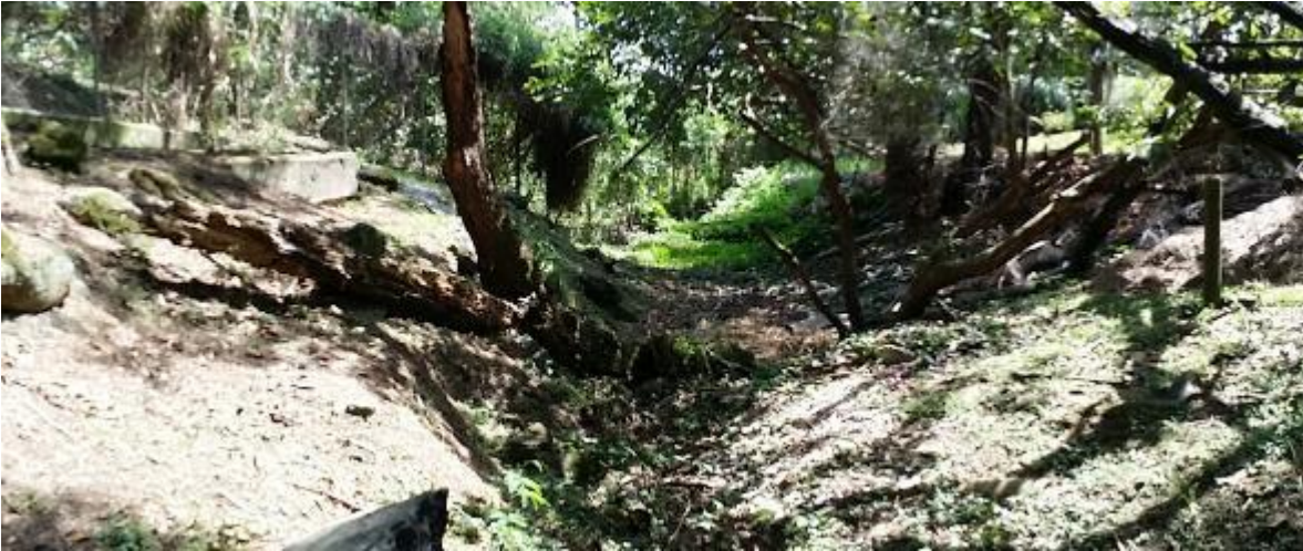
Imagen 30. Drenaje por donde discurren las aguas lluvias en época de invierno.
