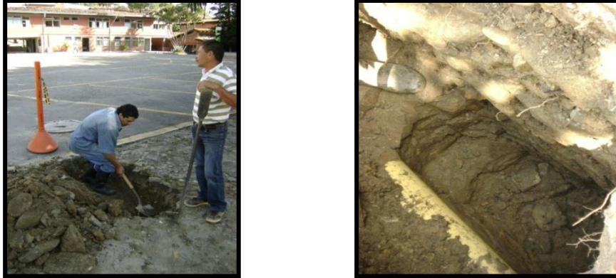
Figura 30. Arcilla plástica encontrada en el Apique AP-5
