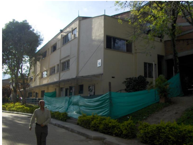
Figura 109. Estado Actual del Coliseo Cubierto
