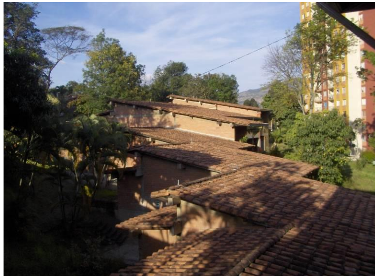
Figura 79. El sistema de espacios construidos (B13)
