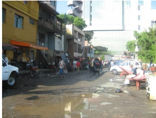
Foto 64. Vías de servicio sin señalización por deterioro del pavimento. Z3_API_15.
