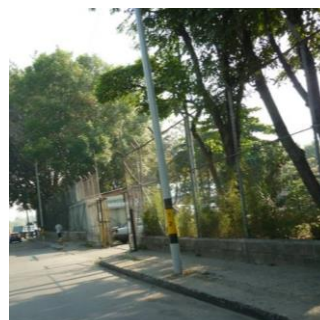
Foto 109. Cerramiento del Complejo Central del SENA costado occidental
