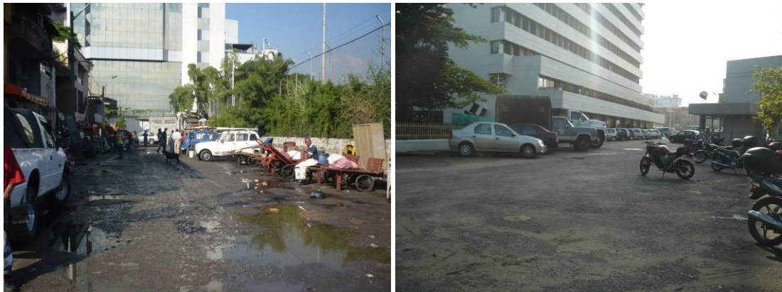
Foto 31. Ausencia de obras de capacidad en vía circundantes al polígono de intervención
