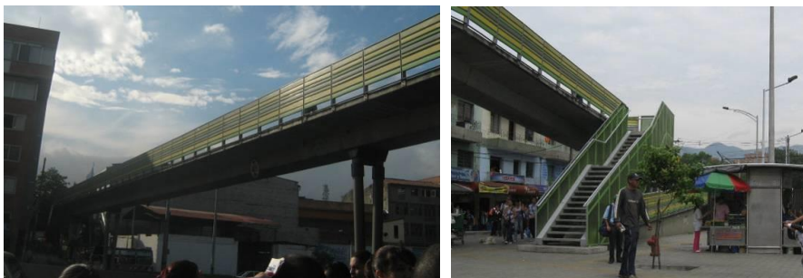
Foto 44. Paso peatonal elevado sobre Av. del Ferrocarril -Calle 51 Boyacá
