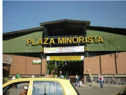
Foto 47. Acceso Peatonal Principal Plaza Minorista
