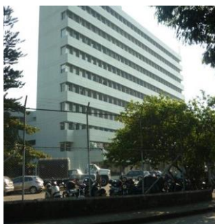
Foto 108. Cerramiento del Complejo Central del SENA costado sur
