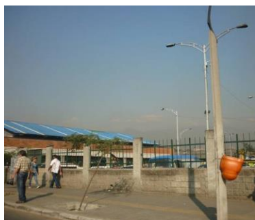
Foto 107. Cerramiento en el costado suroriental de la Plaza Minorista
