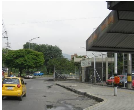
Foto 83. Parqueadero principal calle 51
