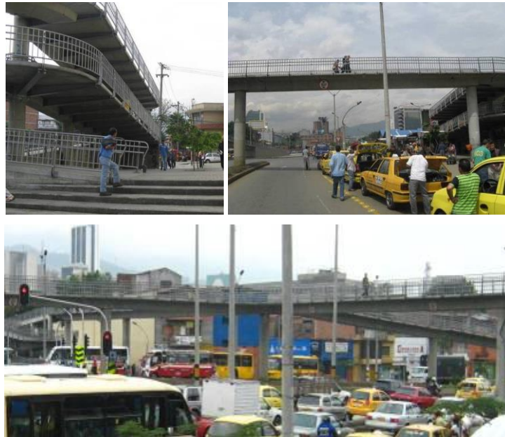
Foto 43. Paso peatonal elevado sobre Av. del Ferrocarril-Plaza Minorista
