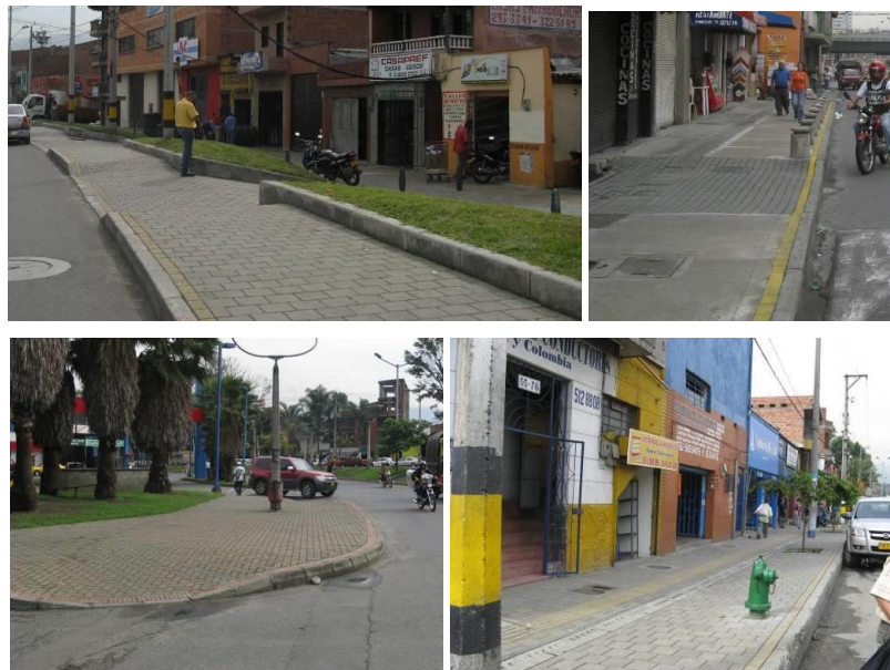
Foto 42. Adecuación de andenes Z3_API_15.
