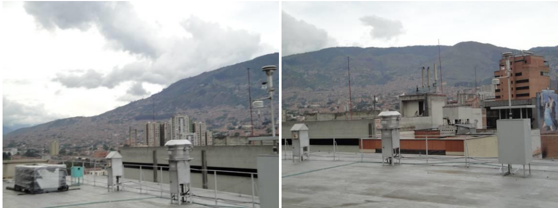
Foto 33. Estaciones de Monitoreo de Redaire en el edificio Miguel de Aguinaga
