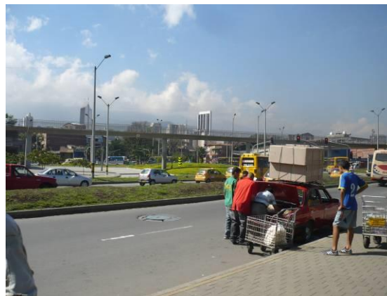
Foto 16. Avenida El Ferrocarril bajo la cual es conducida la quebrada Santa Elena.
