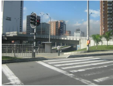
Foto 45. Cruces peatonales en intersecciones semaforizadas Z3_API_15.
