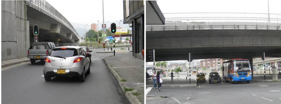
Foto 68. Cruce semaforizado de la calle 50 Colombia con la Av. del Ferrocarril
