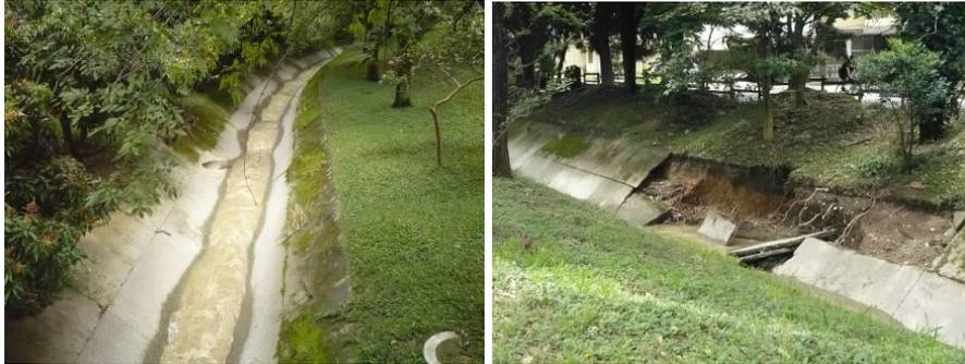
Foto. 29 (Izquierda) Canal trapezoidal en concreto (Derecha) Proceso erosivo margen izquierda
