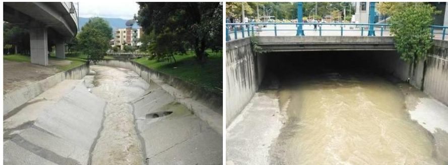
Foto. 28 (Izquierda) Cambio de canal trapezoidal a canal rectangular (Derecha) Cobertura a la altura de la estación Estadio del metro.
