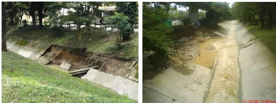
Foto. 43 Procesos de socavación de orillas (Izquierda) Quebrada Ana Díaz, (Derecha) Quebrada La Hueso
