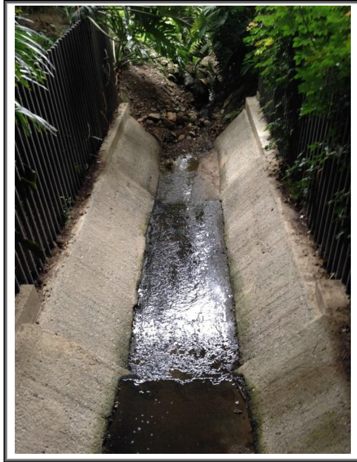
Ilustración 16 Estrechamiento de cauce en cambio después de sección en canal
