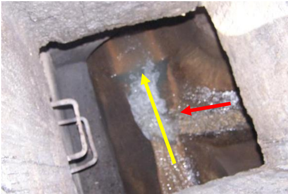
Figura 94. Quebrada El Paraíso (roja), afluente a la red pluvial de Empresas Públicas de Medellín (amarilla).
