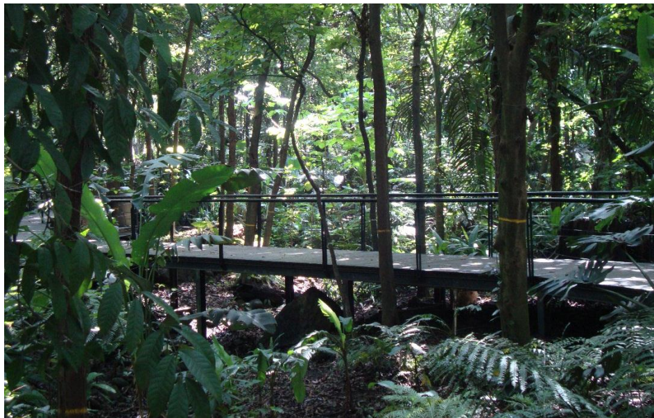
Figura 140. Estructuras palafíticas para evitar mayores impactos al suelo.
