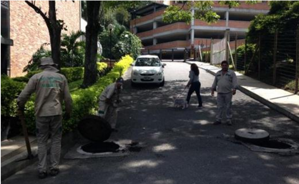
Figura 96. Revisión de manholes sin presencia de la citada quebrada.
