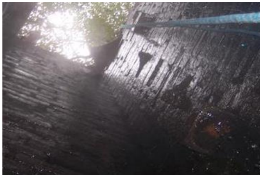
Figura 91. Trabajo de campo para la identificación de la red hídrica – Caja de registro.
