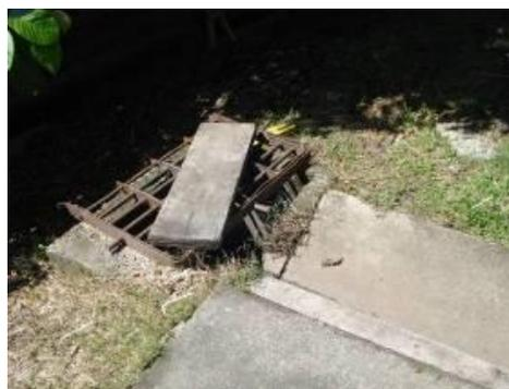
Foto 89. Centro de Acopio y Reciclaje de Pavimentos. Sistema de drenaje de agua de escorrentía y caja recolectora.
