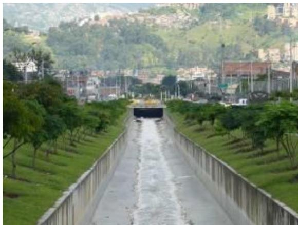
Foto 55 Canal rectangular en concreto, asociado a obras del Metroplús
