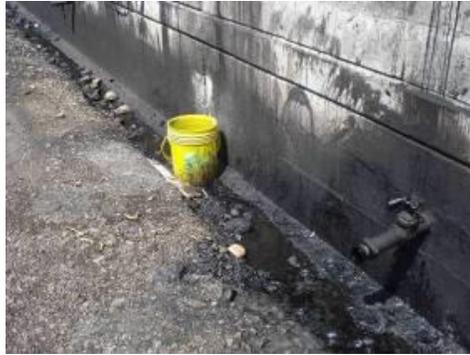
Foto 82 . Centro de Acopio y Reciclaje de Pavimentos. Canaleta alrededor del tanque de contención de hilos que almacenan la emulsión asfáltica; en esta canaleta se observan los derrames de dicha emulsión.
