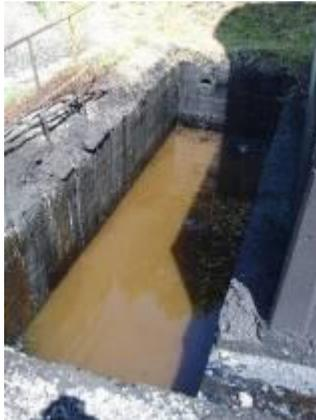
Foto 83. Centro de Acopio y Reciclaje de Pavimentos. Tanque que recolecta agua de escorrentía con posibles derrames de aceites e hidrocarburos, además de los derrames provenientes de la emulsión asfáltica conducidos a través de la canaleta en uno de los costados de la estructura de contención de los silos.
