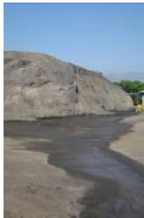
Foto 87. Centro de Acopio y Reciclaje de Pavimentos. Favorecimiento de la pendiente para el drenaje de aguas lluvia y de escorrentía a canaletas y cajas recolectoras. Es de resaltar que el agua en esta zona puede contaminarse con los derrames de aceites e hidrocarburos; esta situación conlleva a la contaminación de cuerpos hídricos y de aguas subterráneas.
