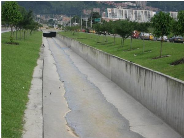
Foto. 32. Canal rectangular en concreto, asociado a obras del metroplus
