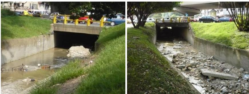
Foto. 28 (izquierda) Cruce quebrada La Picacha con diagonal 74B (Derecha) Alta sedimentación en el canal
