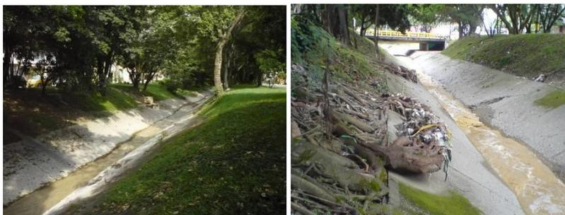
Foto. 29 (izquierda) Canal trapezoidal, quebrada La Picacha (Derecha) Invasión de canal por raíces de árboles, y al fondo cruce con la calle 66B
