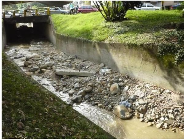
Foto. 46. Acumulación de bloques de rocas y sedimentos. Quebrada La Picacha
