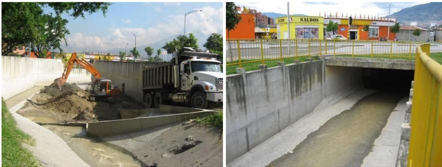
Foto. 31 (Izquierda) Desarenador quebrada La Altavista a la altura de la calle 30. (Derecha) Cruce de la quebrada con la calle 30
