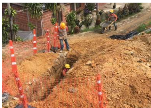
Alcantarillado sector La Aldea parte Baja
