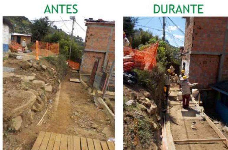
Foto de la Subsecretaría de Servicios Públicos de las obras en Carpinelo (Fuente EPM)
