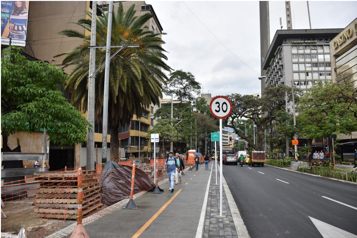
Foto 1. Tramo 2 avenida la playa
