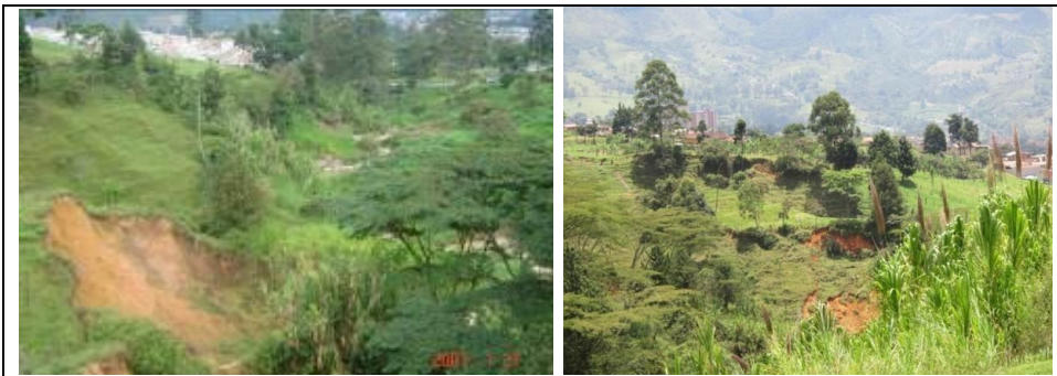
FOTO 134. Deslizamientos parte baja de la quebrada La Limona. Comparativo años 2008 y actual.
