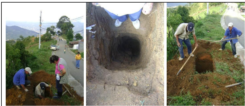
FOTO 132. Panorámica del Apique 12
