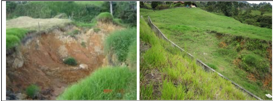
FOTO 135. Zona intervenida y recuperada margen derecha Quebrada La Jacinta o Mauala
