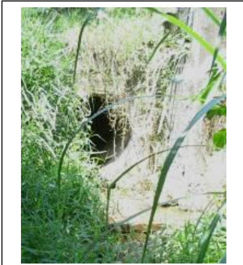
FOTO 88. Cruce con la nueva vía de San Antonio de Prado
