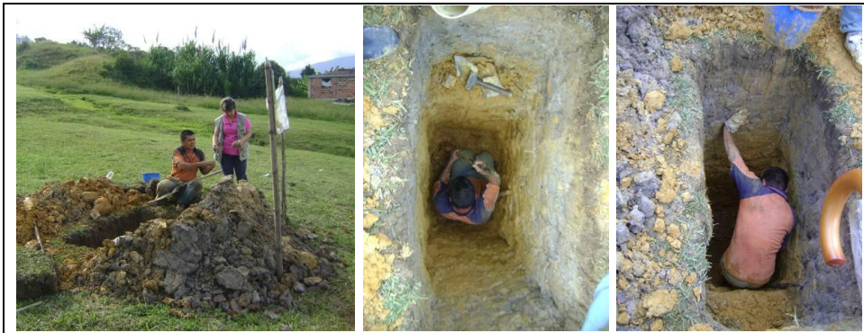
FOTO 131. Panorámica del Apique 11
