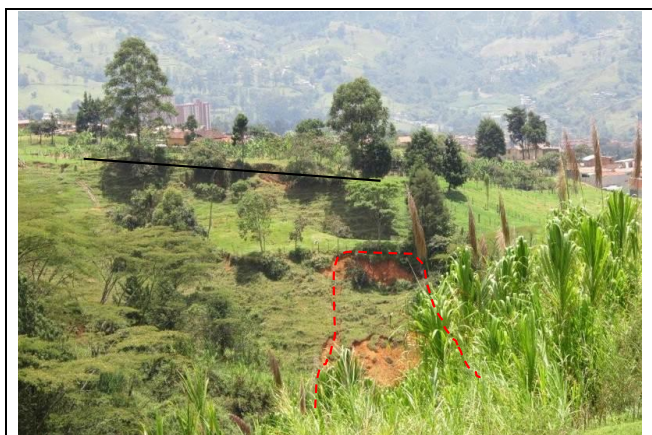
FOTO 103. Panorámica a margen izquierda de La quebrada La Limona, con márgenes inestables.
