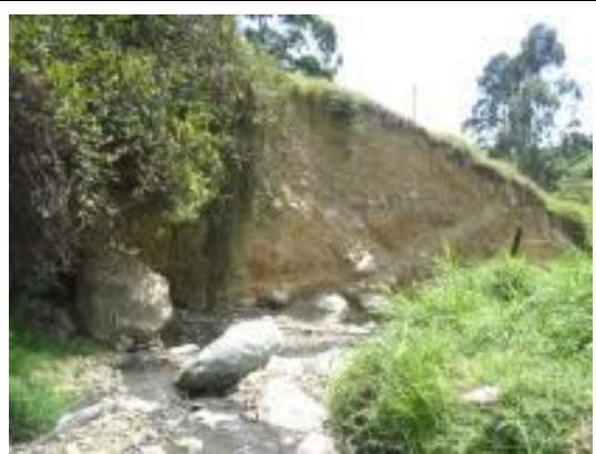
FOTO 75 Socavación en el margen izquierdo
