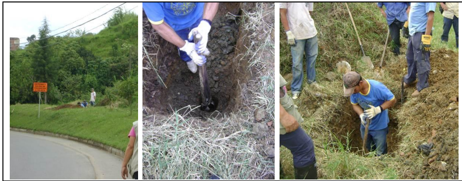
FOTO 126. Panorámica del Apique 6
