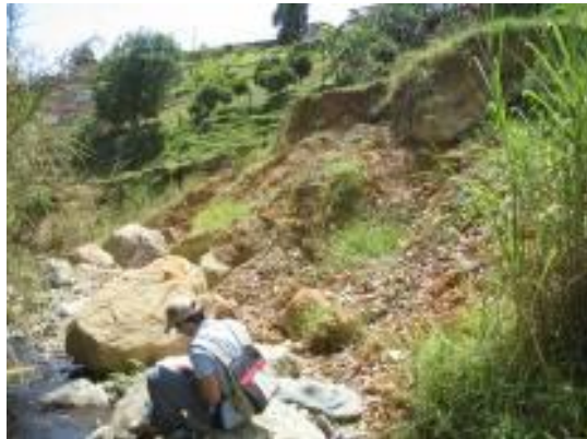
FOTO 76 Socavación y deslizamiento en el margen derecho
