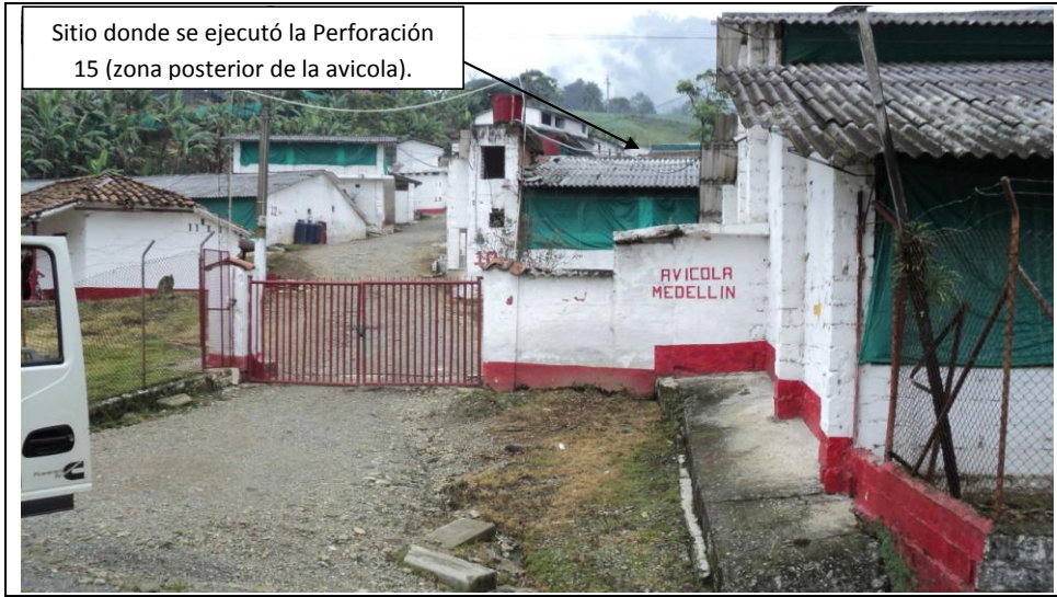
FOTO 120. Panorámica del sitio donde se ejecuto la PERFORACIÓN N° 15
