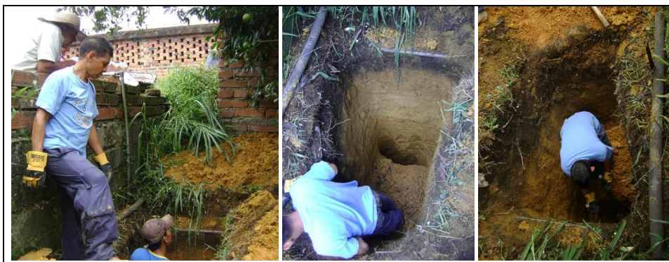
FOTO 124. Panorámica del Apique 4
