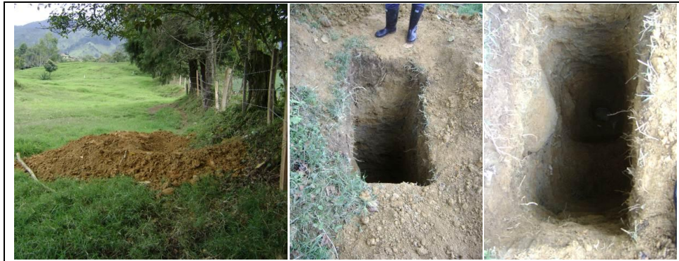
FOTO 127. Panorámica del Apique 7
