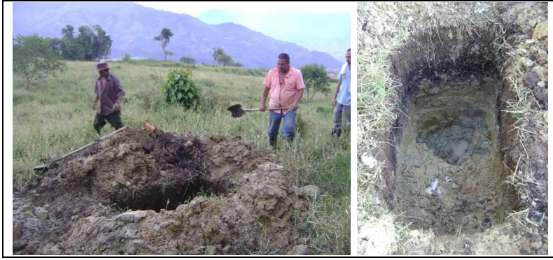
FOTO 130. Panorámica del Apique 10
