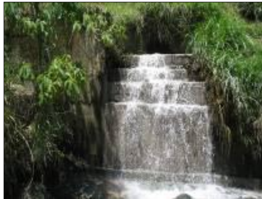
FOTO 82 Escalones en canal de concreto.
