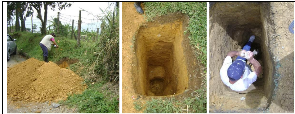
FOTO 121. Panorámica del Apique 1
