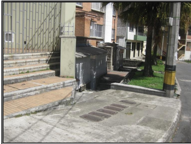
Imagen 21. Medidores sobre la Carrera 27
