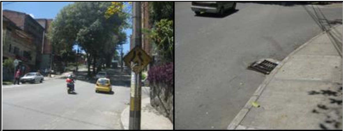
Imagen 18. MH sobre la Calle 49 con Carrera 26
