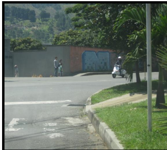
Imagen 16. Sumidero sobre la Calle 49 con Carrera 20B
