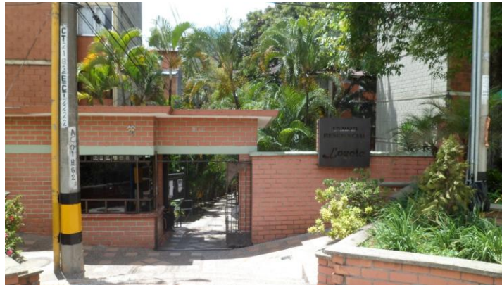
Foto 3. Panorámica de la portería de la Urbanización Loyola.
