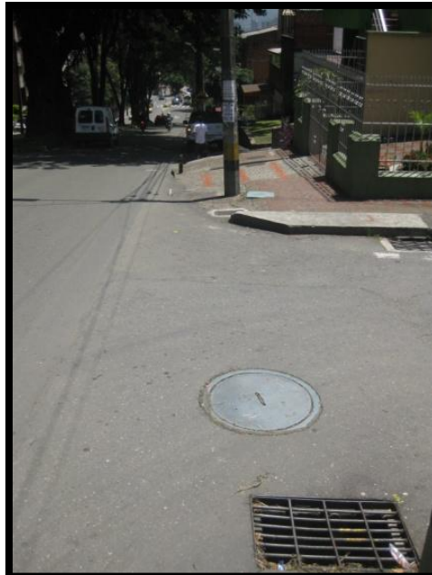
Imagen 15. MH sobre la Calle 49 con Carrera 25
