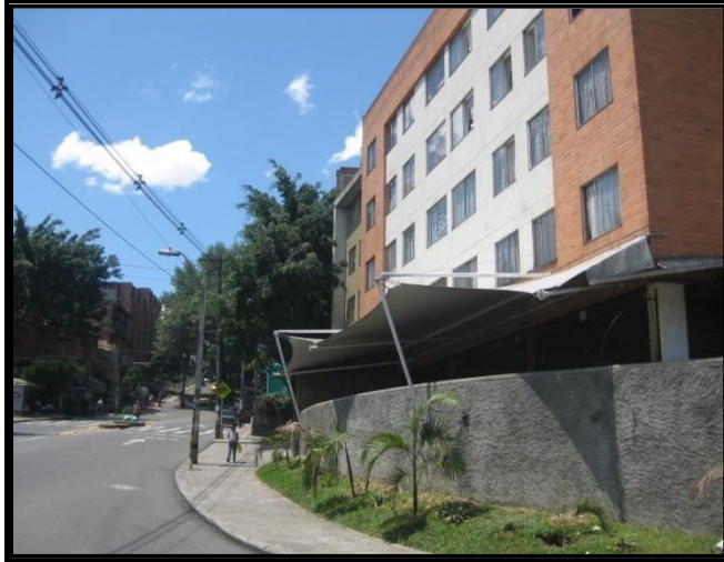
Imagen 1. Edificio Aires de Miraflores
