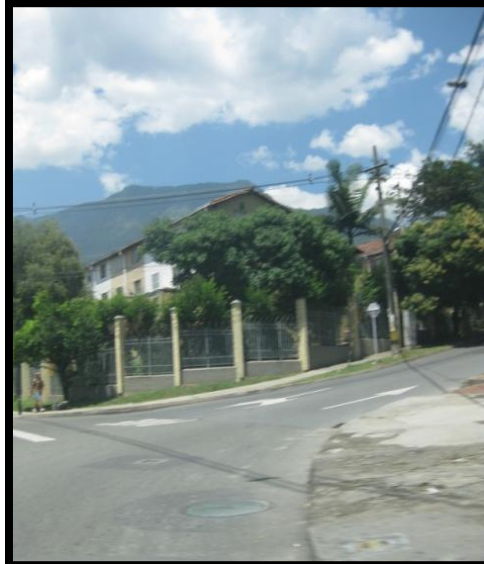
Imagen 19. MH sobre la Calle 49 con Carrera 21
