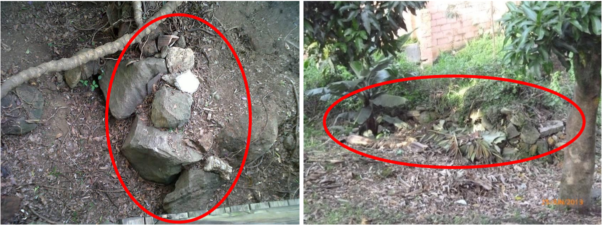
Imagen 3. Enrocado para la conformación de la vaguada
