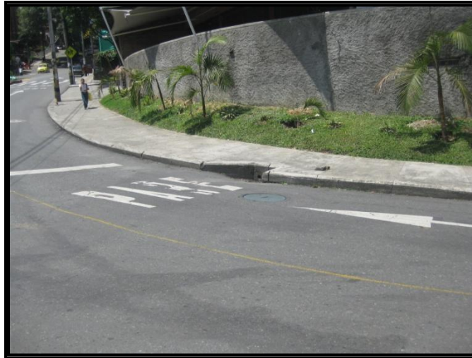
Imagen 17. MH sobre la Calle 49 con Carrera 27
